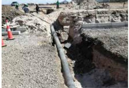
Alrededor de la tubería de alrededor de 40 metros se realizó un trabajo técnico que implicó la soldadura por electro-fusión y el apoyo de un camión fosa para succionar la red donde circulan las aguas servidas.
