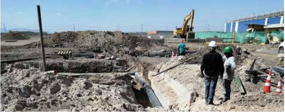
Por encargo de ENEA, nuestro personal trabajó durante cuatro días en la impulsión de una tubería, donde la cota en el lugar a asfaltar era demasiado alta. “Hicimos una capa de estabilizado y luego se asfaltó, para que no quedara al borde de la calle. Se suprimió el tramo para instalar otra tubería paralela, que se ubicara una mayor profundidad que la anterior”, explicó Claudio Pérez, jefe de Terreno de Aguas Santiago Poniente.
