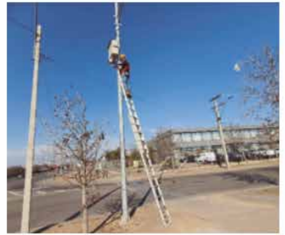
Instalación de antena en parque industrial ENEA, Santiago, Chile.
