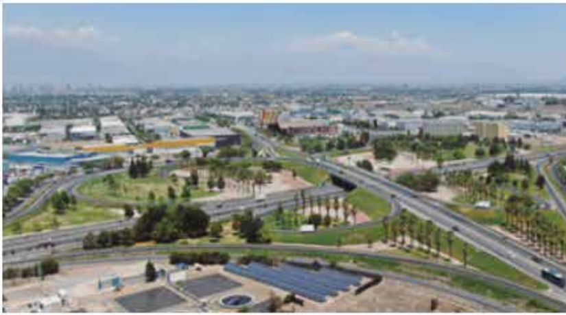
Panorámica del área de servicio de Aguas Santiago Poniente, Santiago, Chile.
